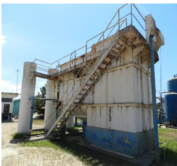
Figura 35 – Sistema de tratamento de água convencional
