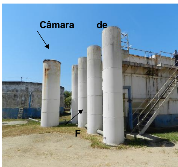
Figura 36 – Sistema de tratamento de água –Filtros e câmara de contato
