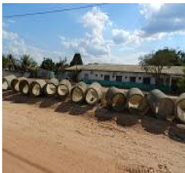
Figura 65 - Manilhas dispostas na margem da obra
