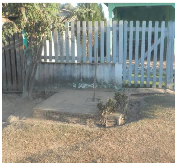
Figura 60 – Fossa rudimentar construída na frente do lote
