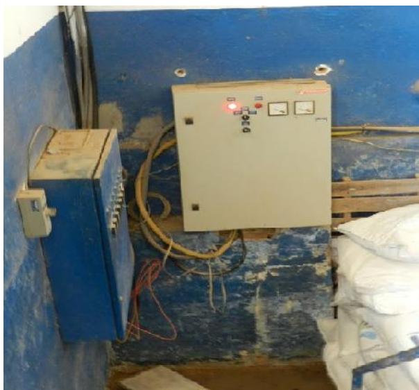
Figura 47 – quadro de comando da pressurizadora
