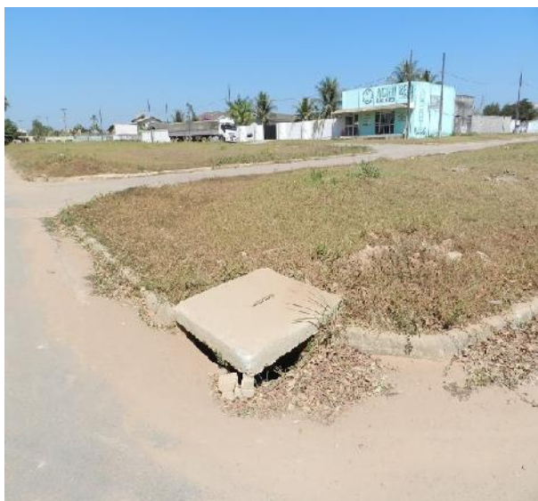
Figura 69 – boca de lobo locada de forma inadequado
