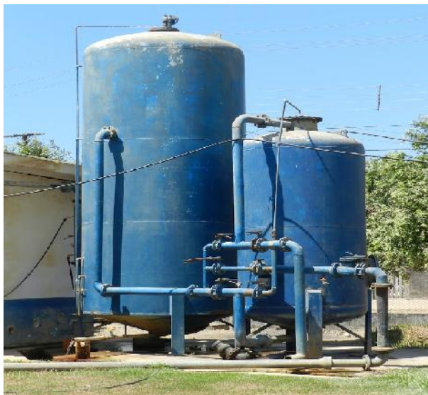
Figura 33 – Sistema de tratamento de água - Filtro Russo
