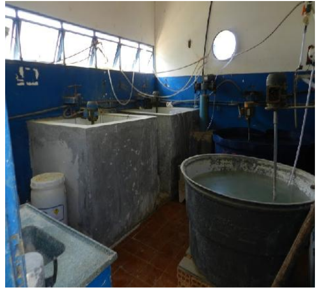
Figura 38 – Tanques de mistura produtos química
