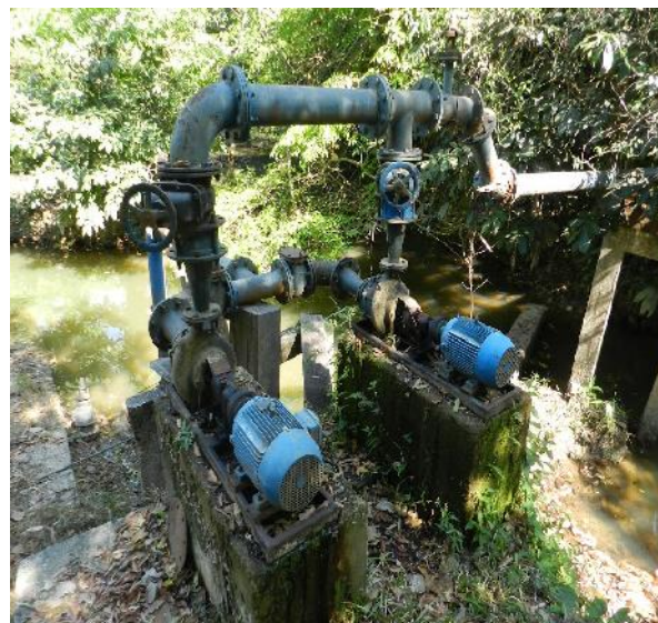
Figura 29 - Captação superficial – recalque
