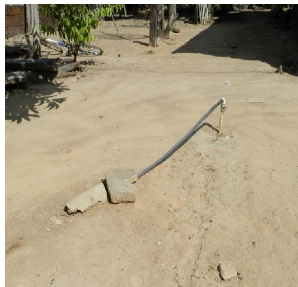
Figura 58 – Ligação do cavalete
