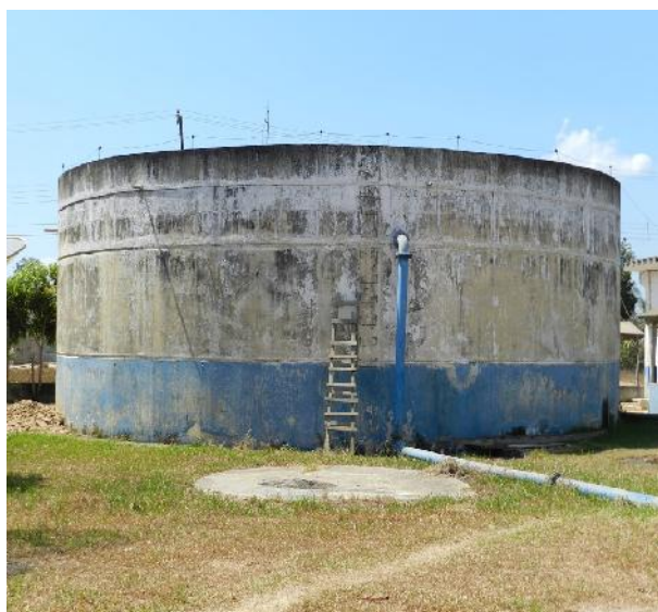
Figura 44 – Reservatório de água 400 m³
