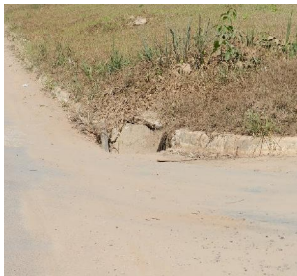
Figura 70 – Tapa quebrada e afundada.
