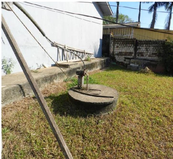
Figura 24 – Poço raso particular
